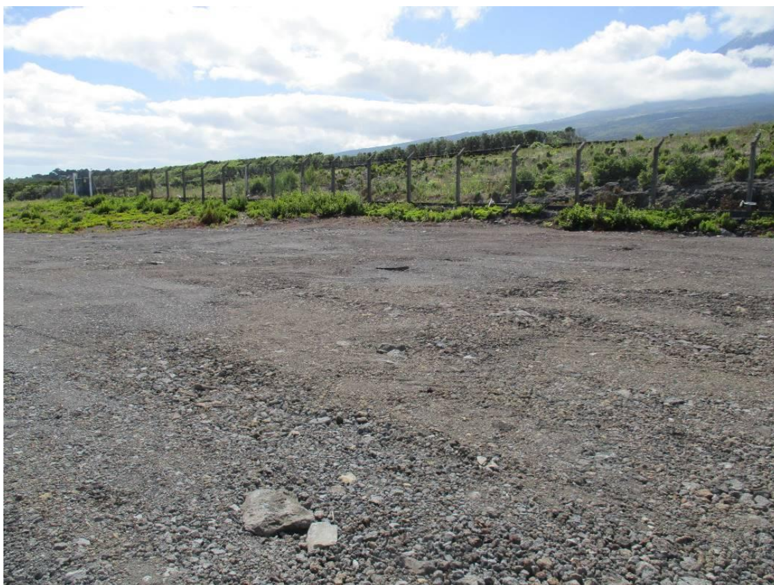
Fotografia 01 - Aspeto Final da Escavação e Regularização do Terreno
