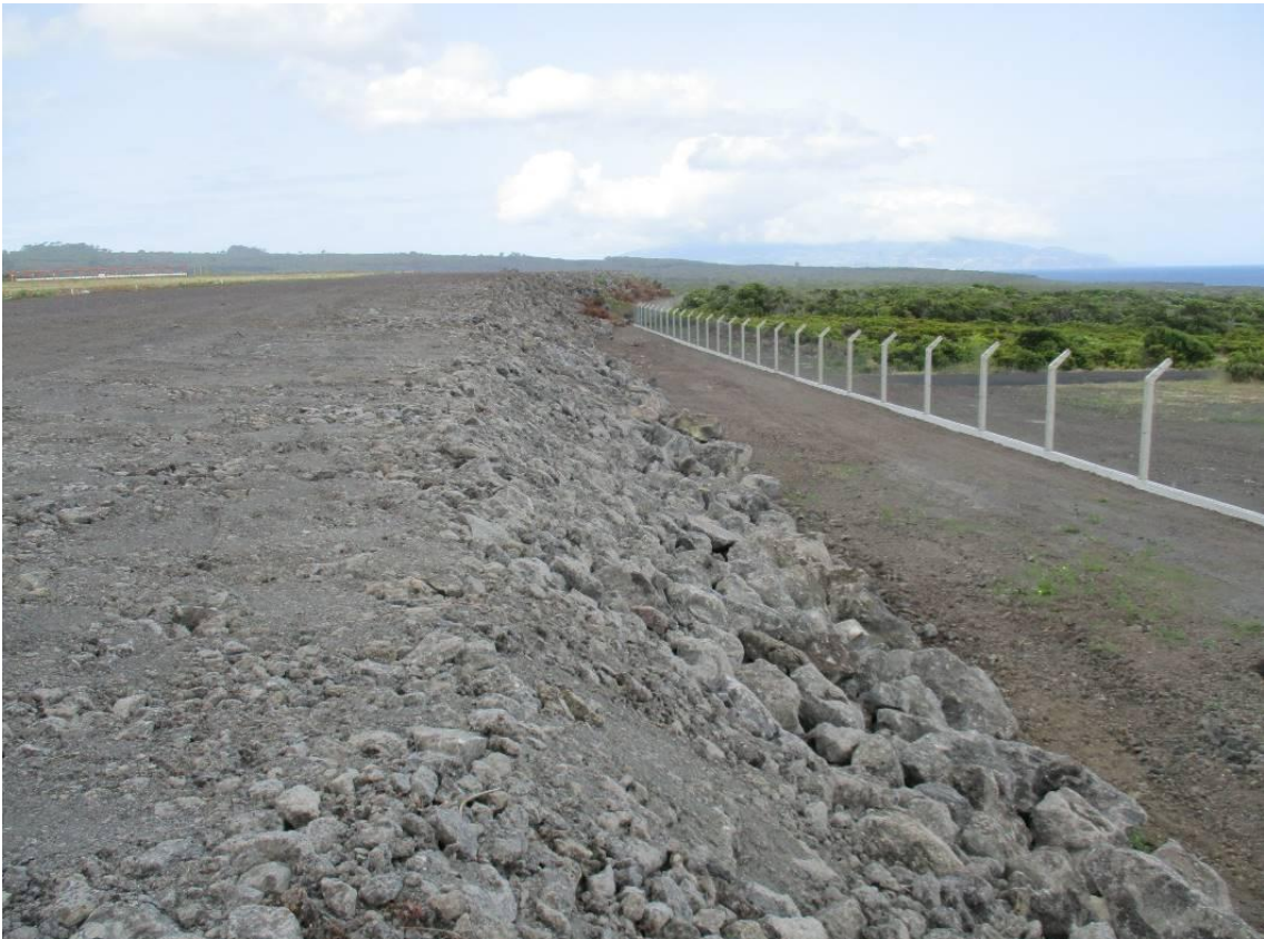
Fotografia 03 - Talude do Aterro
