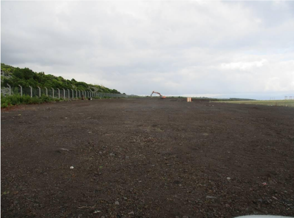
Fotografia 04 - Aspeto Geral e Final da Escavação e Regularização do Terreno
