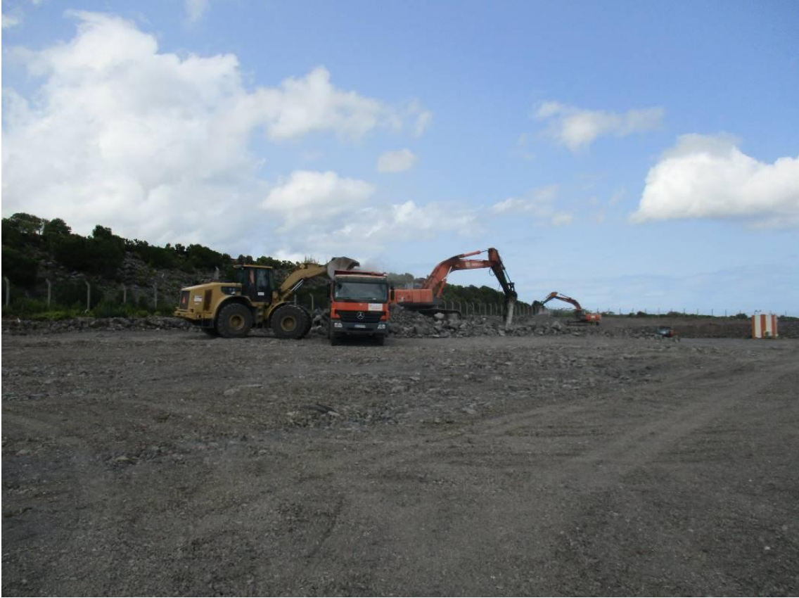
Fotografia 02 - Reperfilamento do Talude de Escavação
