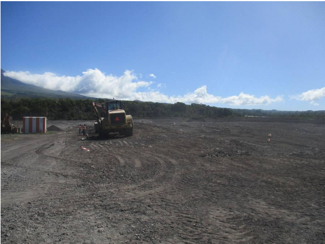
Fotografia 05 - Aspeto Geral da Escavação/Regularização
